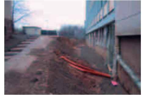
Sanierung der Fassade.
